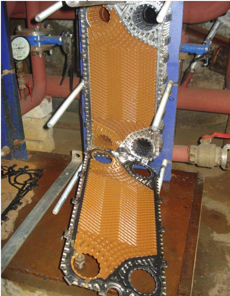
Состояние рабочей поверхности со стороны нагреваемого контура к моменту остановки теплообменника
